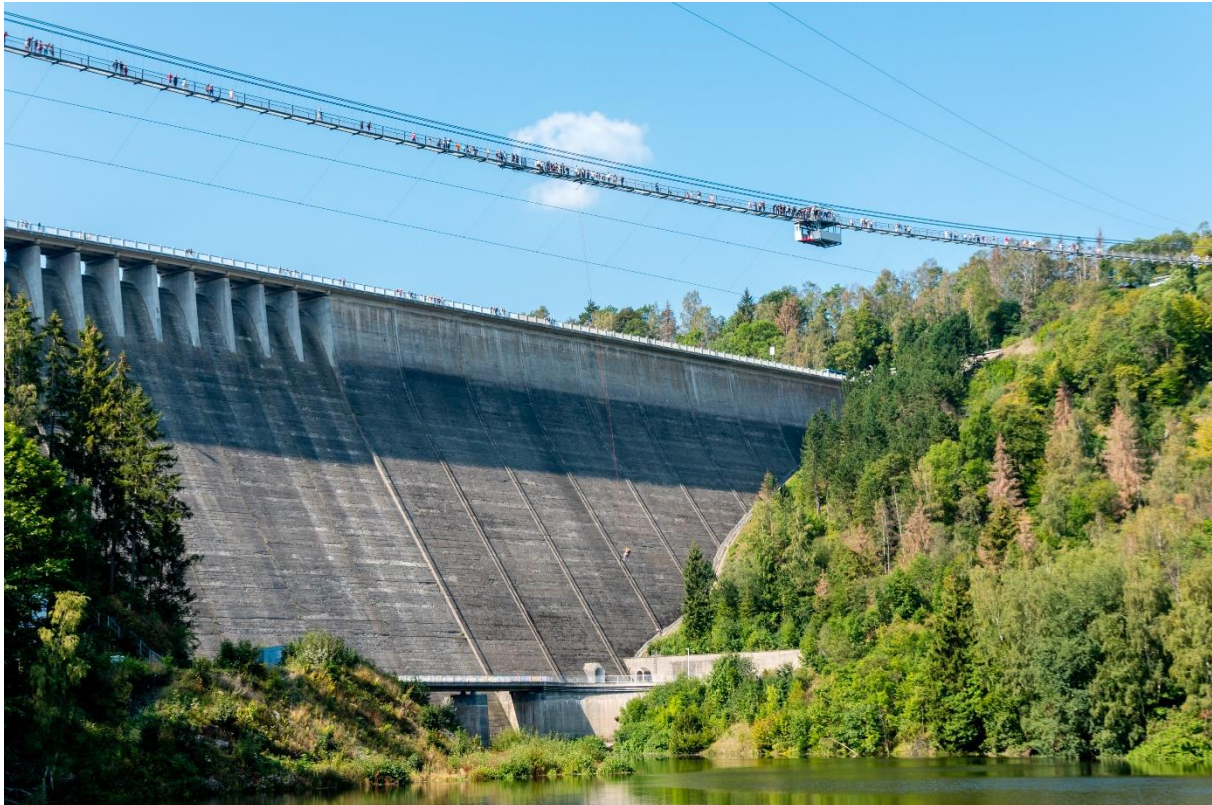
Abbildung: Talsperre (Foto: Adobe Stock)
